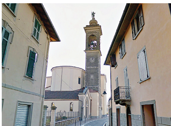
Il campanile di Paladina è stato ristrutturato con i fondi dell'8 x mille
